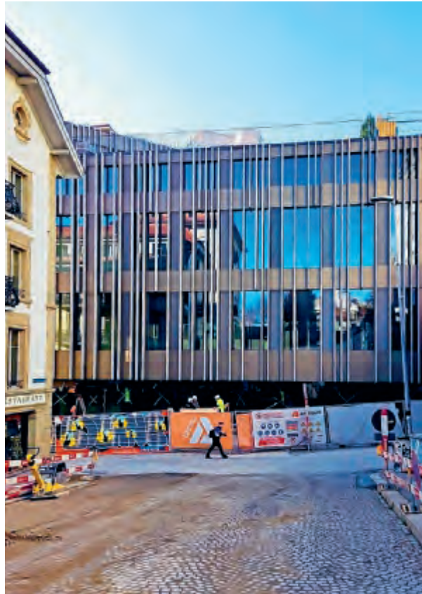
Dieses Bild veröffentlichte der Staat Freiburg im März 2025. Die Fassade des Erweiterungsbaus besteht aus einer raumhohen Verglasung für maximale Tageslichtnutzung und einem Holzgeflecht. (Foto: Denis Suchet/BDO Architectes)
